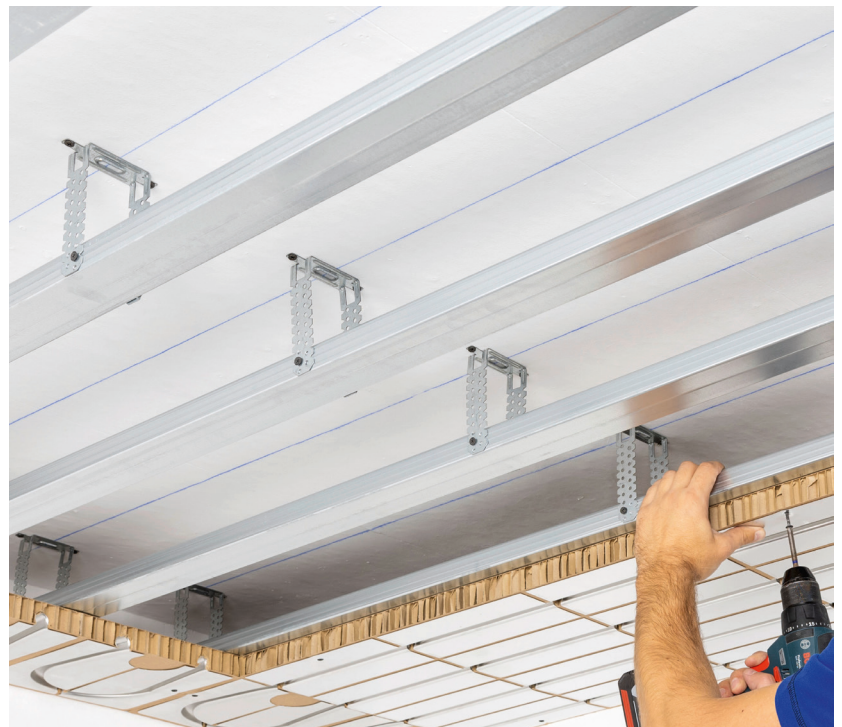
Vollflächige, einfache Montage auf Trockenbauprofilen
