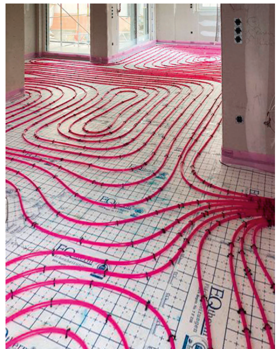
Die mit Spezialvelours kaschierte Glasfaser-Klettplatte verzahnt sich optimal mit EQtec 5 SPEED Klettrohren.
