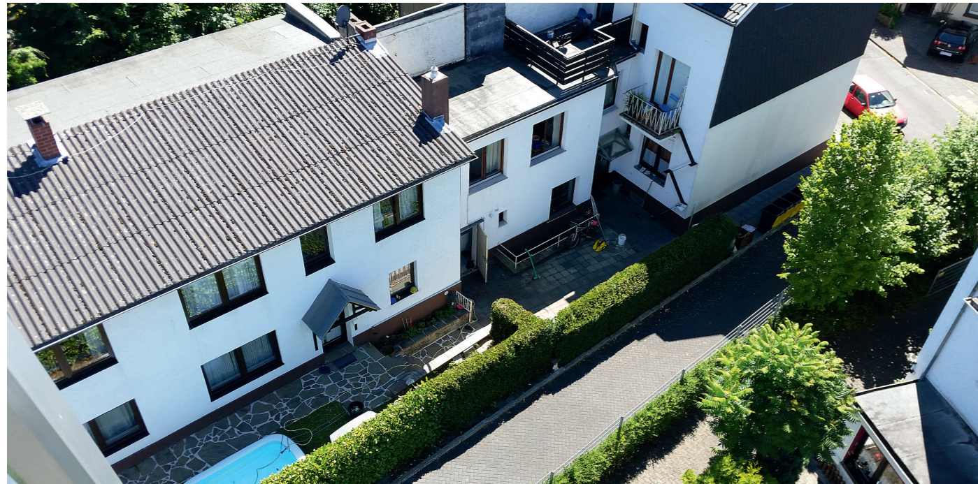
Im Mehrfamilienhaus von 1895 mit Anbau von 1949 in Bad Honnef wurden bei der Heizungssanierung Flächenheiz- und Kühlsysteme, eine EQ Air Compact 1030 Wärmepumpe und ein E-Smart Energiemanagementsystem eingebaut. Hinzu kommt eine PV-Anlage.
